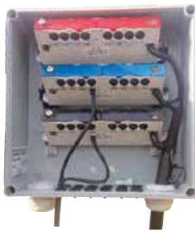
>> Caja de distribución aérea con bornera de ajuste elástico de 250A
