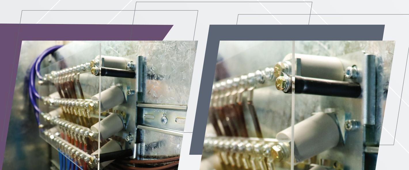
Los portabarras escalonados compatibles con 4DIN4520 y 4DIN4530 tienen un 5to escalón para colocar Covers (Tapas de protección). Los 4DINAP40 y 4DINTRI traen orificios para Holders (columnas negras de sostén), sobre los cuales se coloca el Cover de protección. Los Covers comercializados de forma estándar son para sistemas de 10 o 15 contactos.
